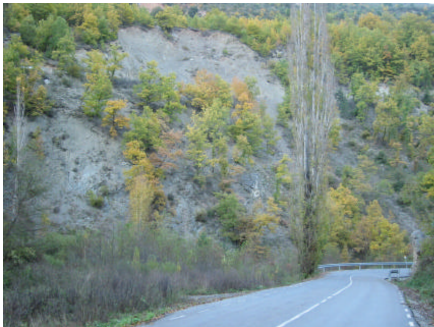
Fotografia 20: Aspecte del vessant B indicat al plànol 5 ; aquest es troba força degradat, amb alguna cicatriu puntual i localment algun arbre torçat.
