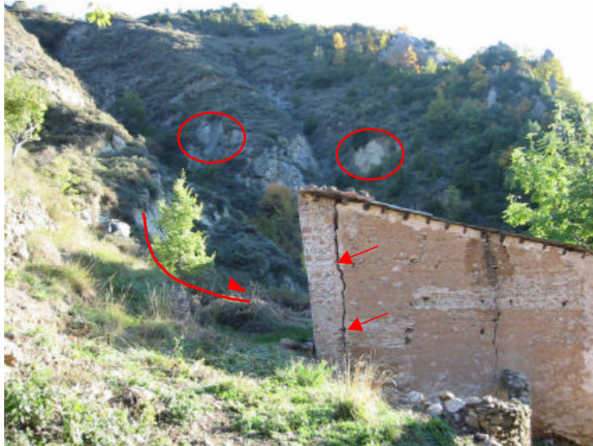
Fotografia 8: Vista dels vessants constituïts per argiles i guixos, (B i C, plànol 2). Observar les múltiples inestabilitzacions del vessant, algunes d'elles indicades amb cercles (despreniments) i fletxes corbes (lliscaments). A primer terme es pot veure una casa antiga afectada per una esquerda vertical oberta.
