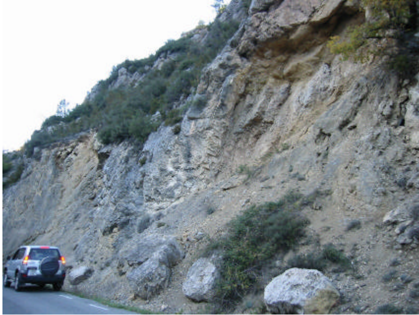
Fotografia 5: Exemple de despreniment ocorregut en el marge de la carretera de Noves de Segre, fora de l'àmbit d'estudi.
