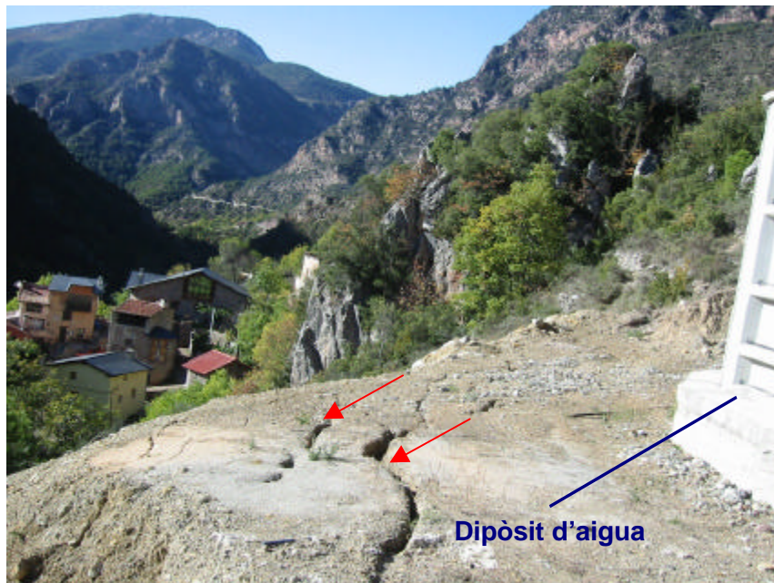
Fotografia 8: Vista dels vessants constituïts per argiles i guixos, (B i C, plànol 2). Observar les múltiples inestabilitzacions del vessant, algunes d'elles indicades amb cercles (despreniments) i fletxes corbes (lliscaments). A primer terme es pot veure una casa antiga afectada per una esquerda vertical oberta.
