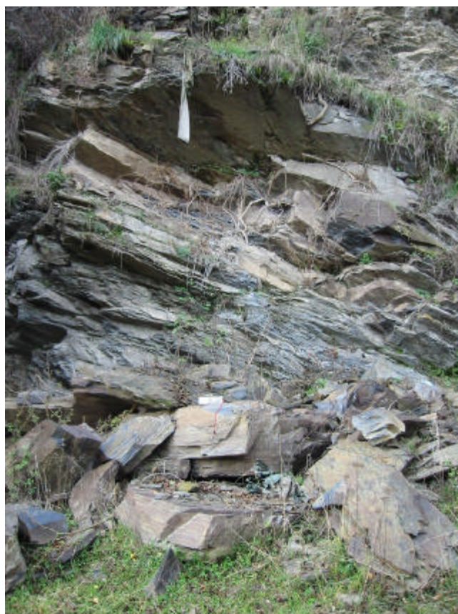
Fotografia 42: Detall del despreniment (a, plànol 13) on s'observa la cicatriu i el material mobilitzat al peu.
