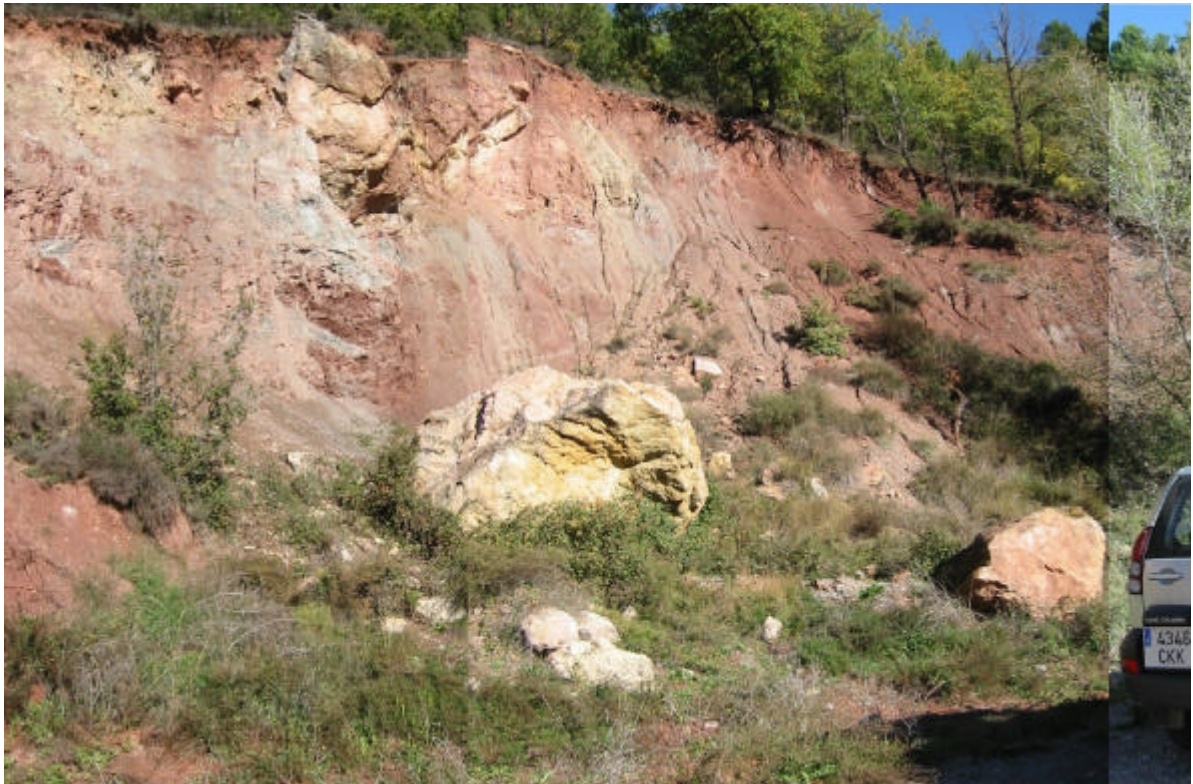
Fotografia 4: En la present fotografia s'observen dues cicatrius de desprendiments i els dos blocs caiguts, el de l'esquerra de 60 \text{ m}^3 i el de la dreta de 4 \text{ m}^3 , (c, plànol 1).
