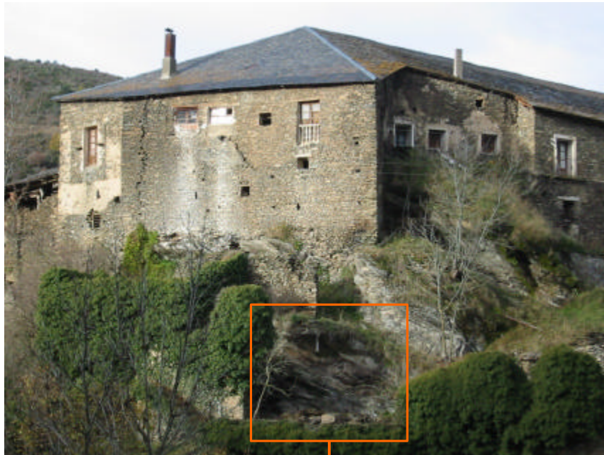
Fotografia 41: Despreniment afectant el substrat rocós de calcoesquists, situat al peu de cal Cervós, (a, plànol 13).
