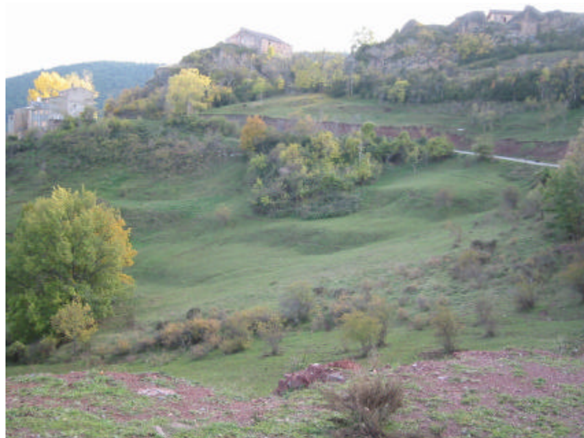
Fotografia 13: Fotografia on s'observa l'aspecte irregular del terreny ocasionat per inestabilitats de baixa magnitud, modelades pel pas del temps, afectant les argiles vermelles, ( b del plànol 3 ).
