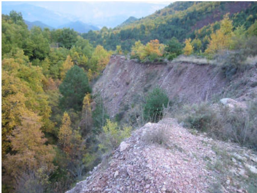
Fotografia 16: Marge dret del torrent que travessa el sector occidental d'Argestues, (a, plànol 4), constituït per llims i argiles violades amb clasts d'ordre mil·limètric a centimètric.
